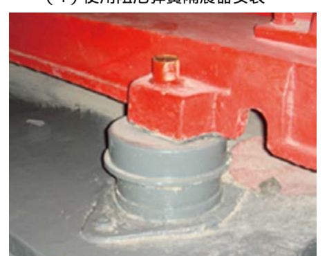
图8 使用弹簧隔震器安装
