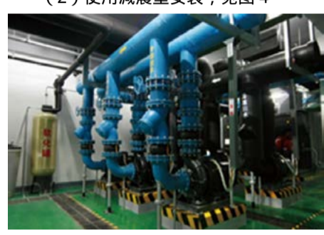
图4 使用减震垫安装
