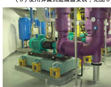
图5 使用弹簧式避震器安装示意图
