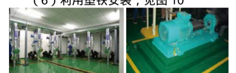
图10 利用垫铁安装示意图
