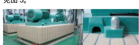
图3 使用减震垫与基座组合减震安装
